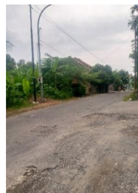
Gambar 7. Aksesibilitas Jalan Utama
